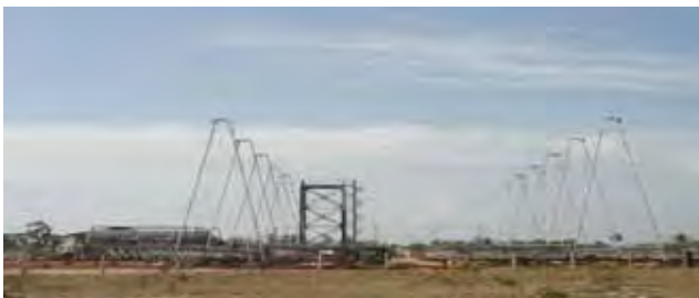
Fig. 5.5 Solar MED System
